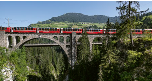
3 Solisviadukt/Solis, 863 m ü. M.
